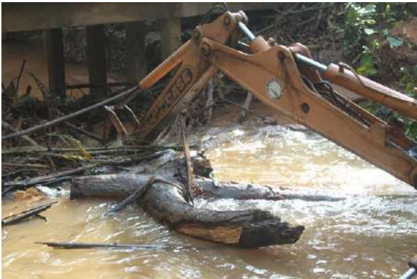
Keterlibatan golongan kanak-kanak dalam aktiviti mitigasi banjir di sekeliling kawasan sungai yang dijalankan di sekitar Kampung Betong. Membuka laluan air Sungai yang tersumbat akibat banjir di Kampung Peneh untuk mengurangkan risiko banjir dan memastikan aliran air yang lancar.
