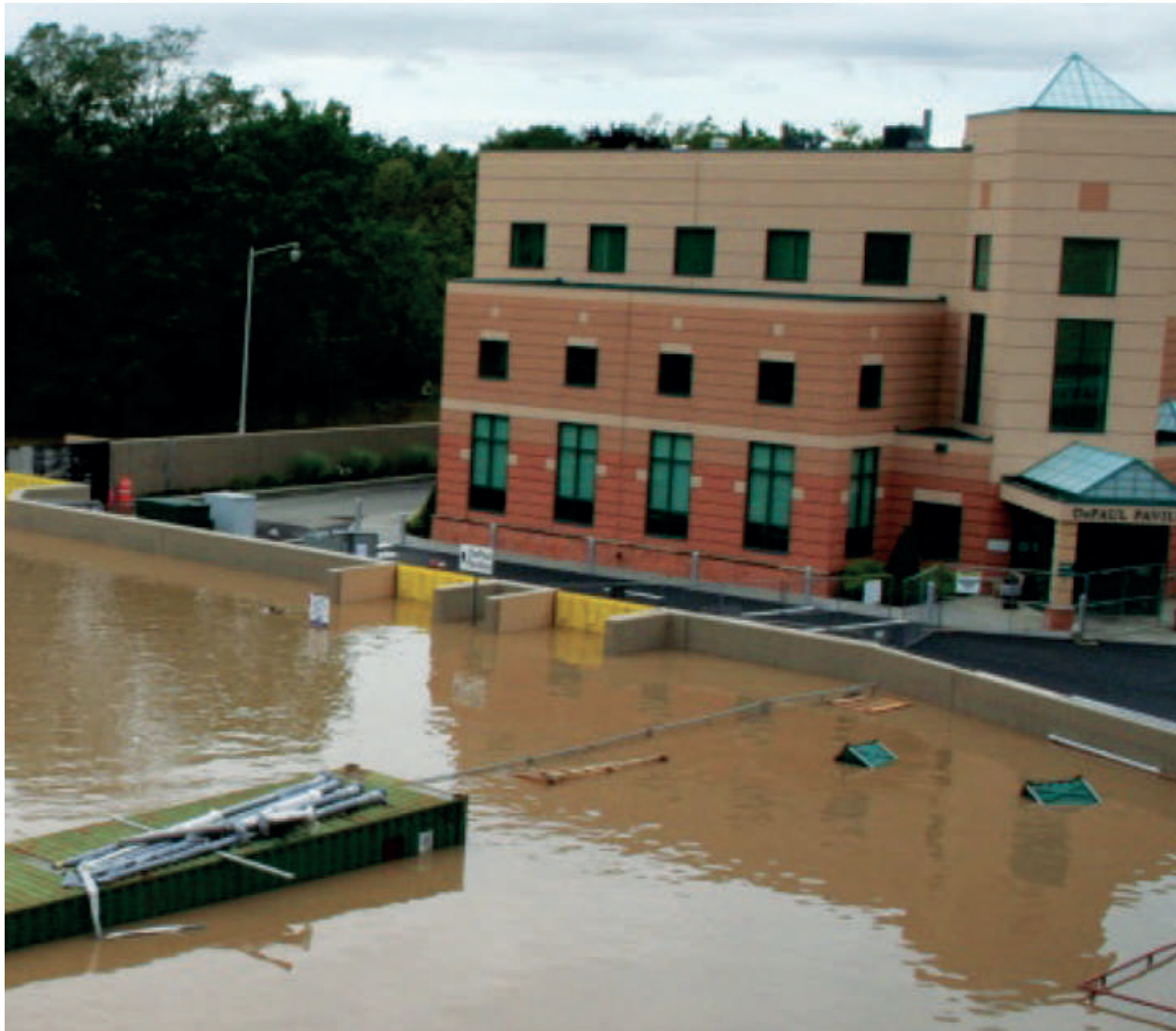
Atas Hospita Our Lady of Lourdes Memorial di Binghamton, New York. Sebuah dinding tebatan banjir dibina pada tahun 2011 untuk memastikan hospital untuk tetap beroperasi sewaktu kejadian banjir.
